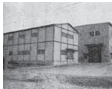
▲ 動橋工場の新設
