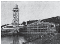
▲ 福田工場の新設
