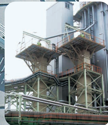
バケットエレベータ Bucket Elevator
